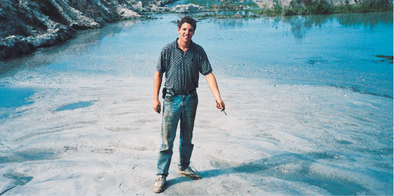
Dallas Shepard, gerente general de Lake Suzy Utilities, señalando la excelente compactación de la arena de filtro bombeada por la draga Ellicott Serie 370.
